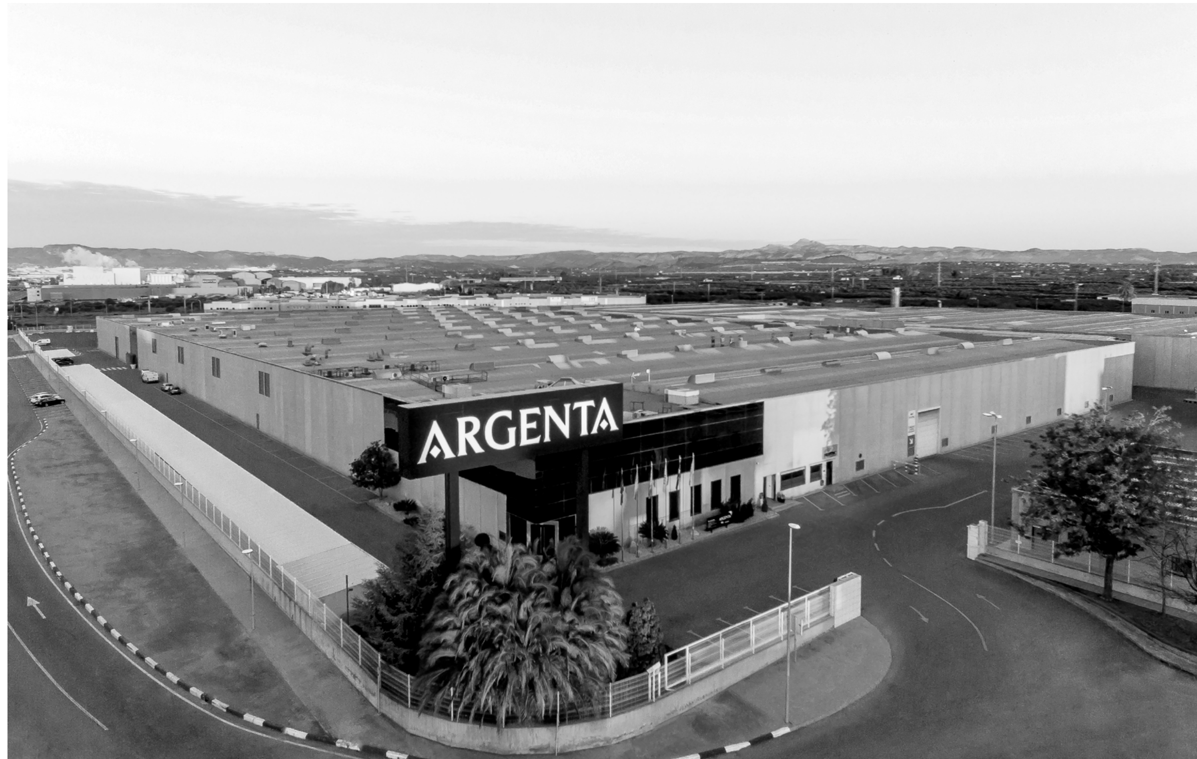
Oficinas Centrales Argenta Vila-real (Spain)
