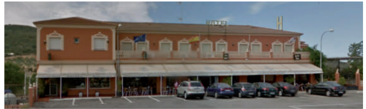
ANTES BEFORE AVANT VORHER
